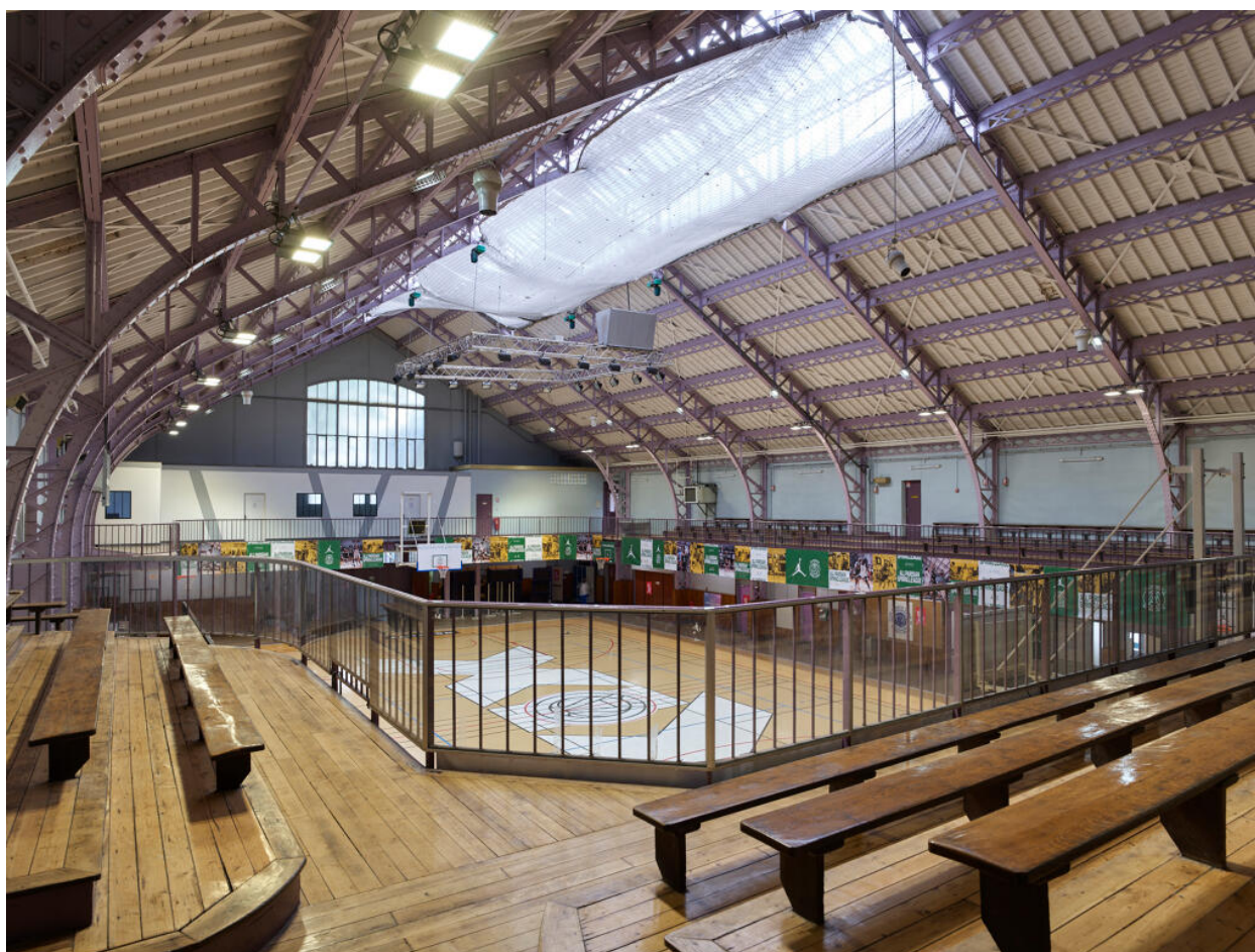
Le gymnase Jean Jaurès.
