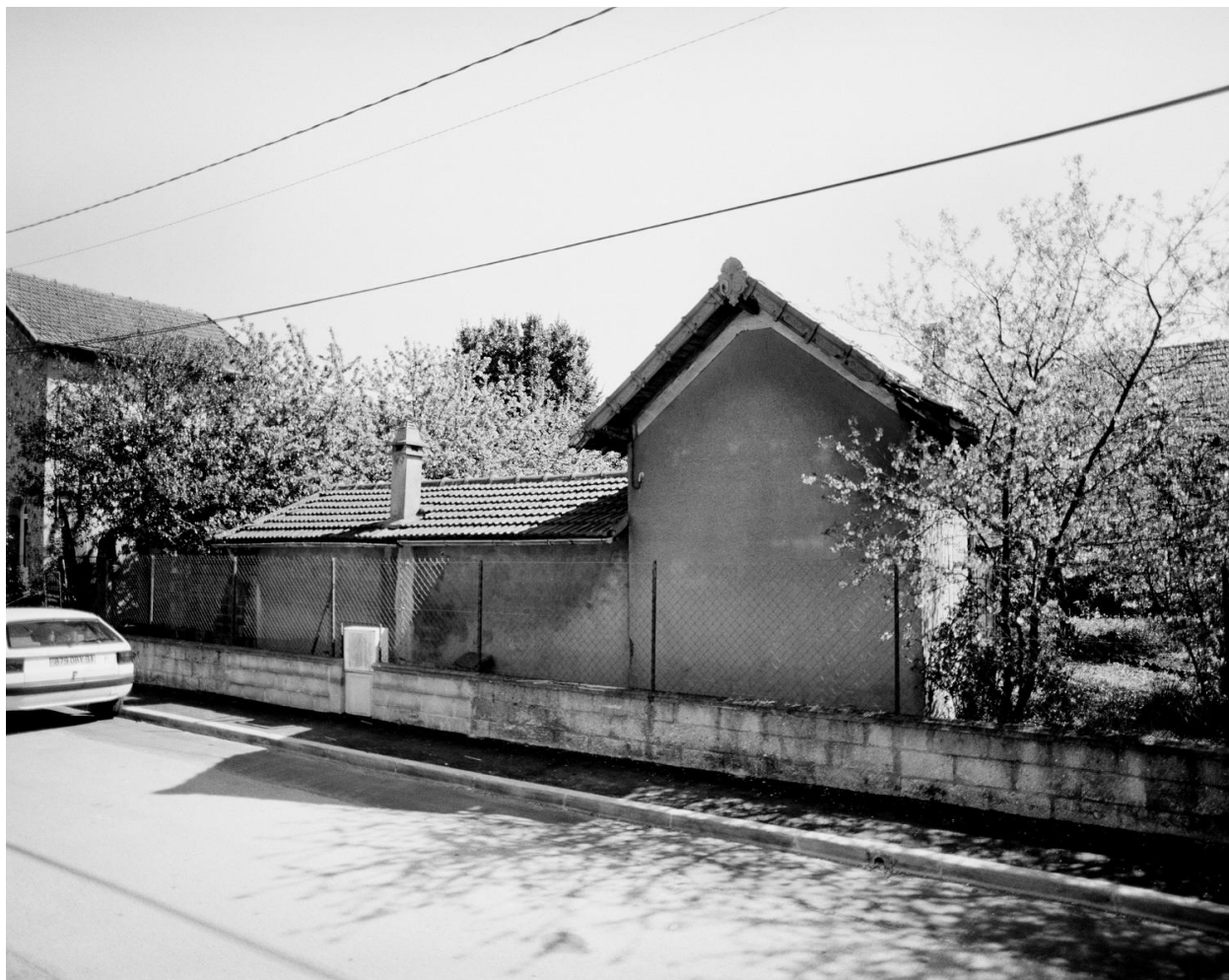
Vue de la façade arrière du cabanon.
