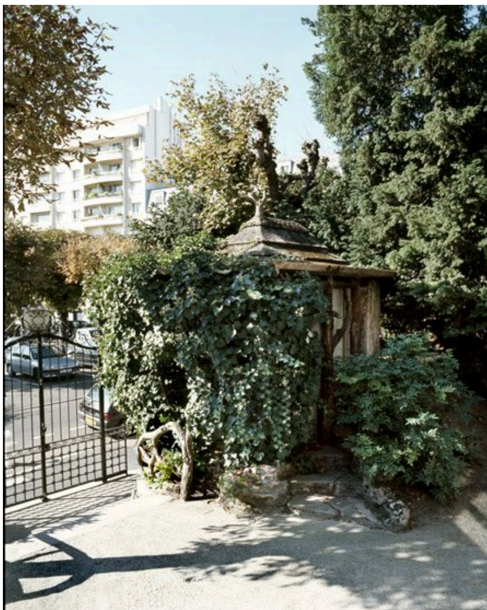
Seconde fabrique de jardin construite en béton imitant le bois, 95 rue des Héros Nogentais.
