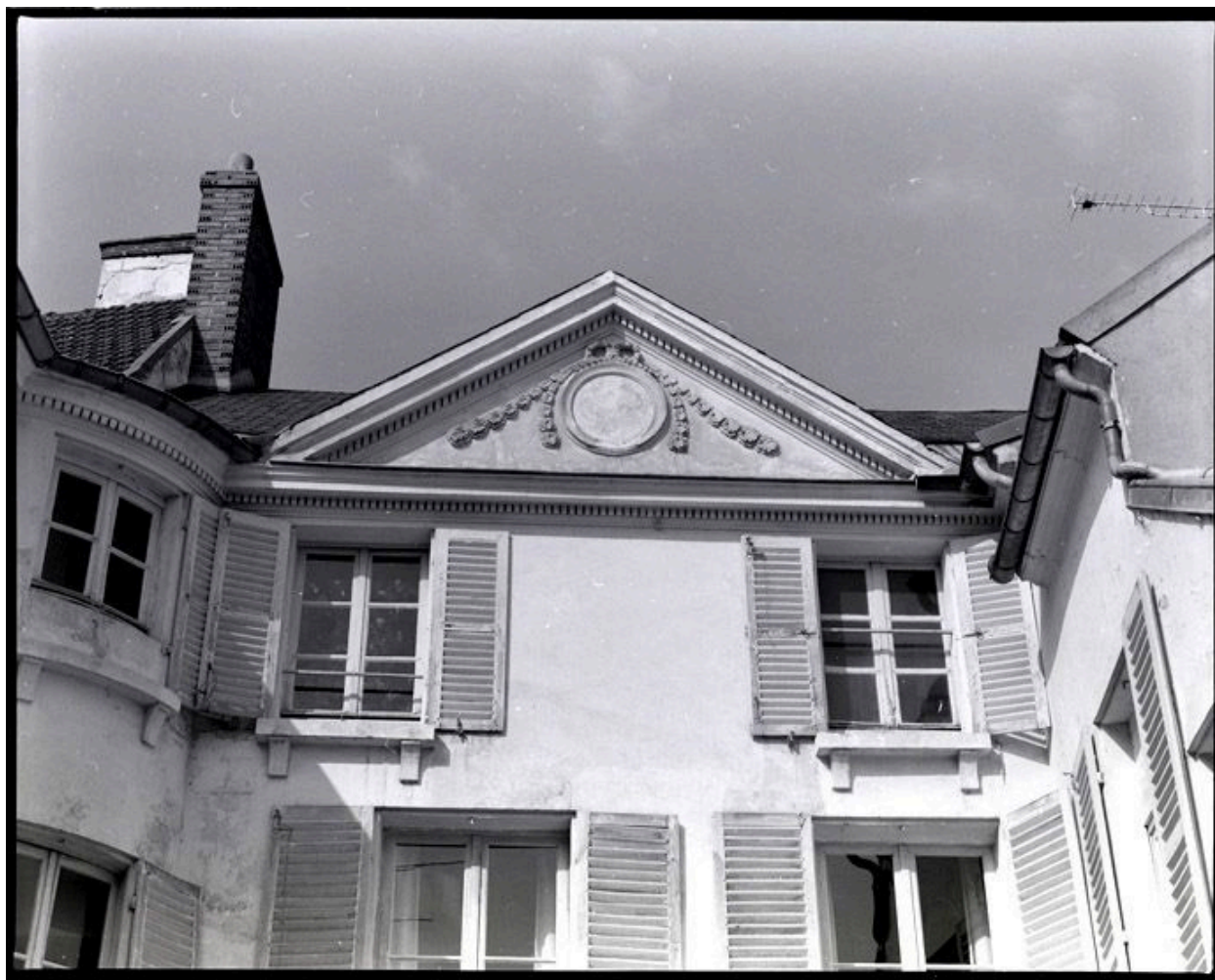
Hôtel particulier, Sangle (rue de la) 44. Façade sur cour.
