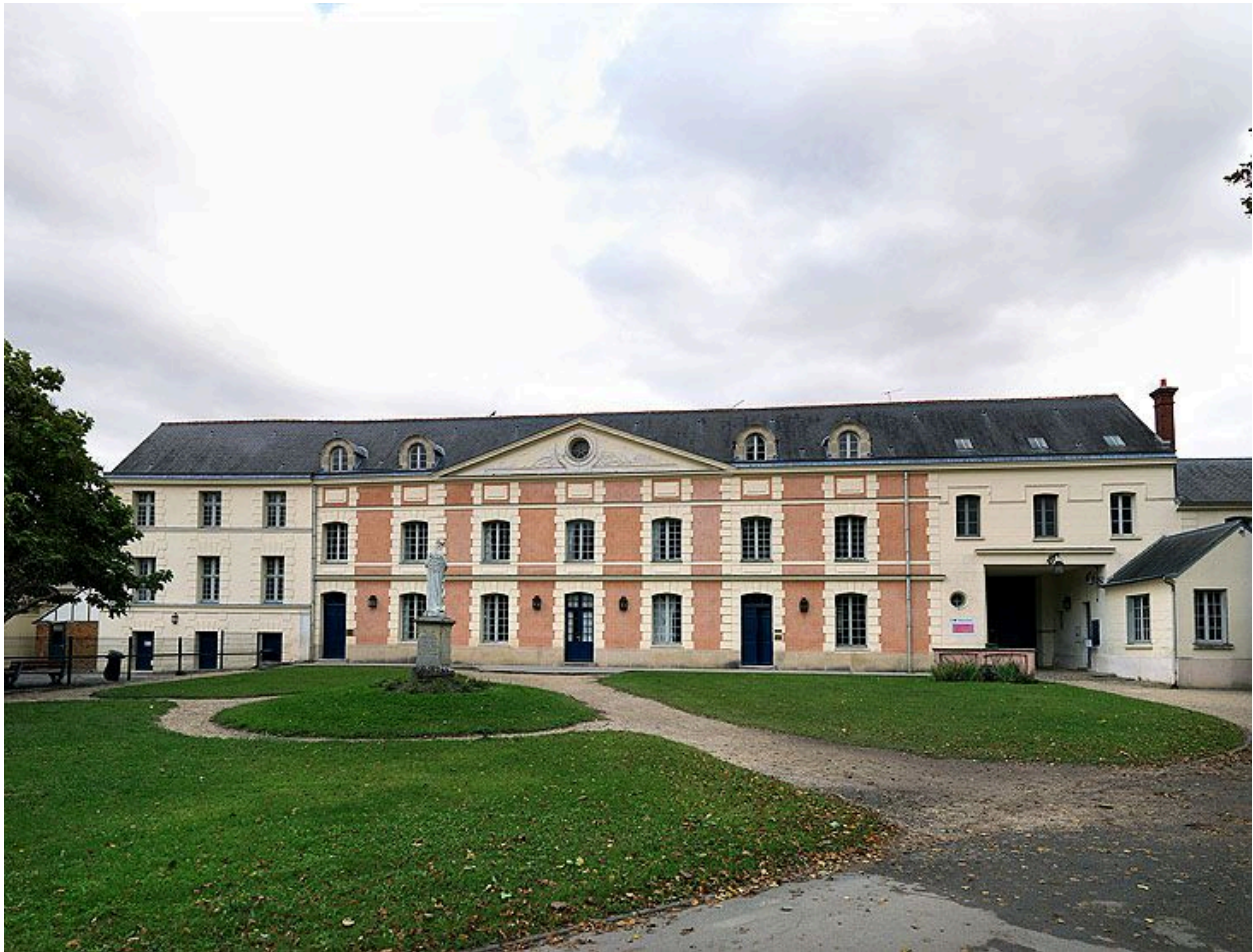
Le bâtiment du XVIIIe siècle : façade occidentale (sur jardin).
