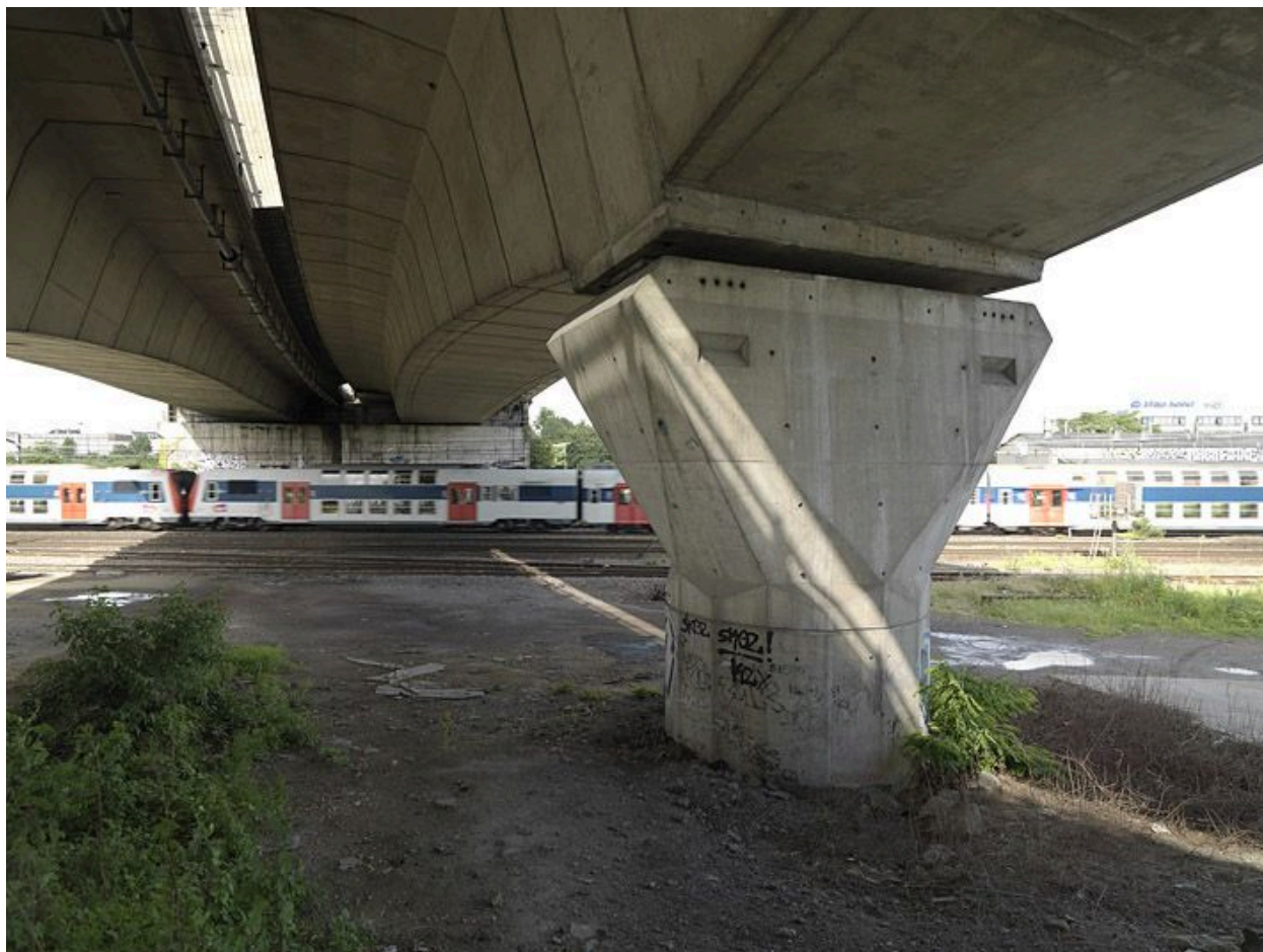
Choisy-le-Roi, Alfortville, Vitry-sur-Seine. Pont de Choisy de l'A86. Vue sous le tablier, à l'endroit où le viaduc enjambe les voies de chemin de fer de la ligne Paris-Orléans, à la limite entre Vitry et Choisy.
