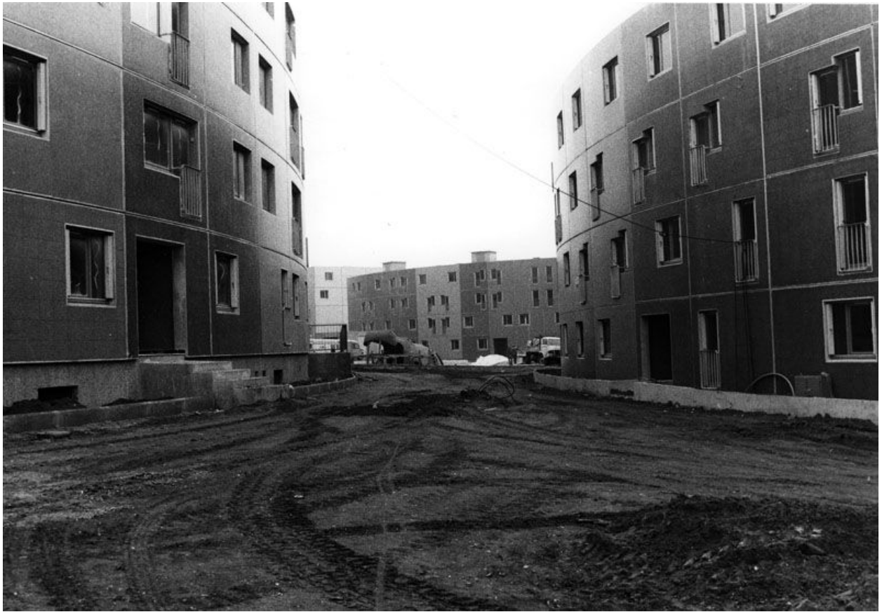
La Noé. Photographie du chantier prise le 17 avril 1973, depuis la première enceinte de la place du Bestiaire, vers la seconde, accueillant l'hippopotame en cours de construction. (Mairie de Chanteloup-les-Vignes).
