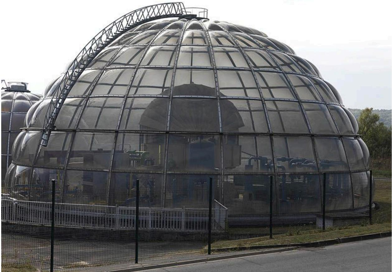
Coupole abritant les salles de commandes. Gros plan sur les coupoles constituées de feuilles de polyméthacrylate de méthyle (plexiglas) coulées et posées sur des ossatures métalliques tubulaires.
