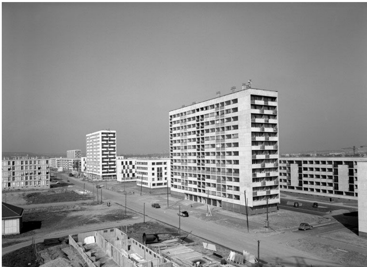
Le chantier de construction avenue de Bourgogne. Photographie, 1961. (Ministère de l'Écologie, MRU 36808012)
