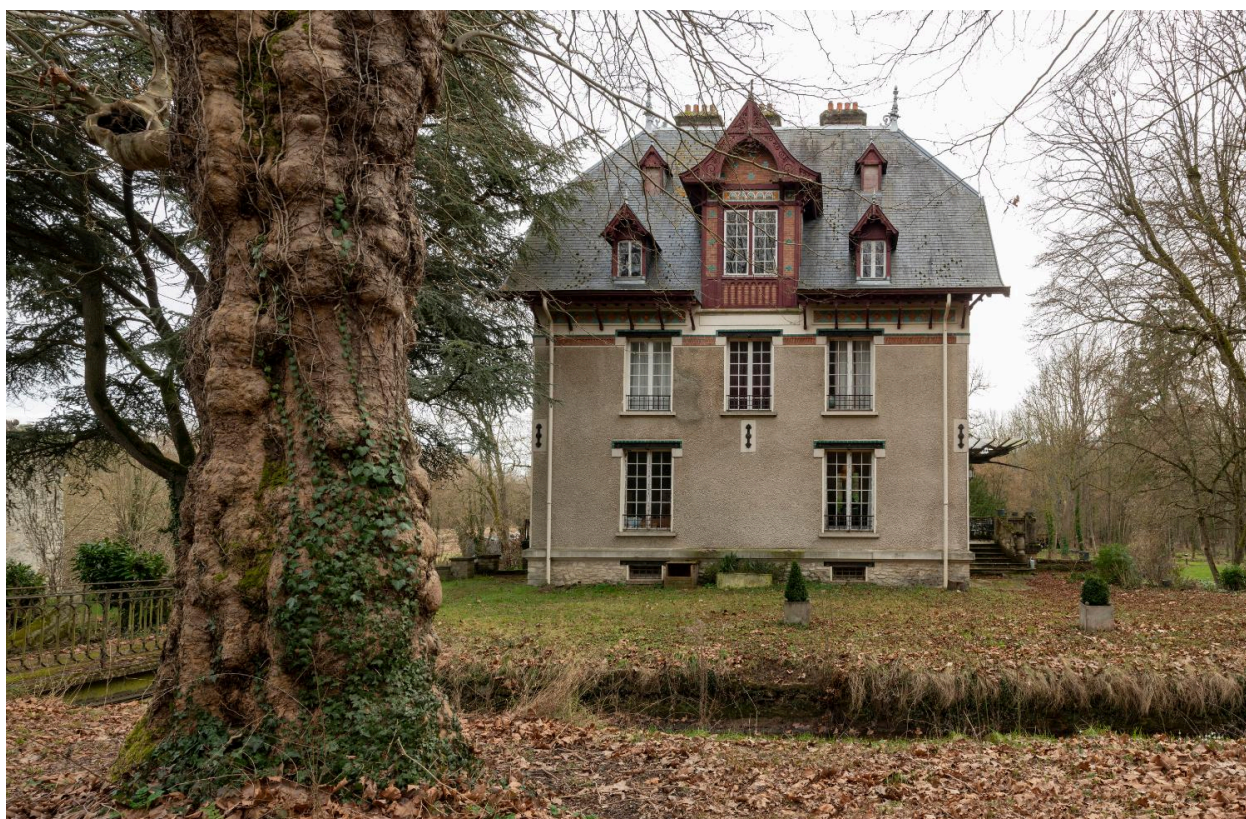
Façade postérieure, nord-ouest
