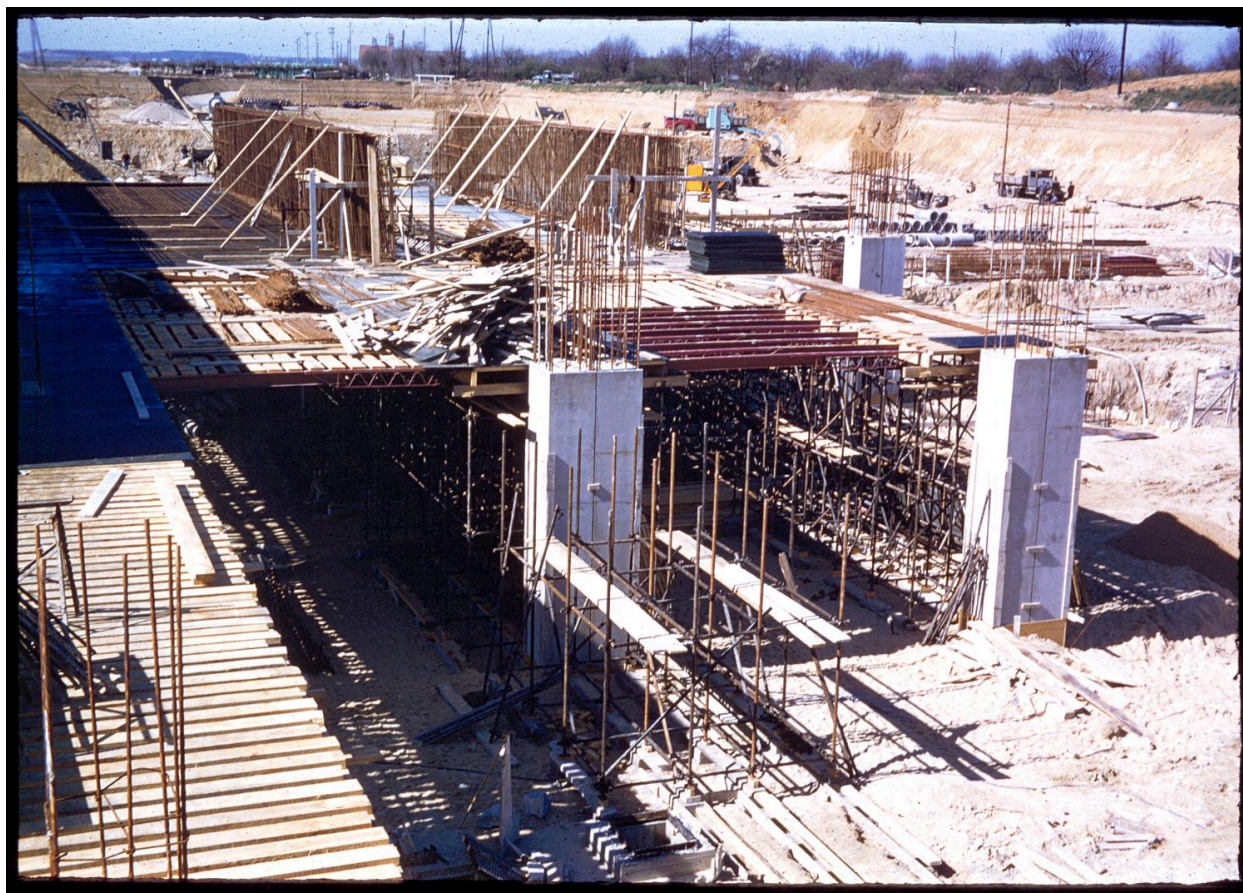
1956 1960 Construction du nouveau tracé de la Nationale 7, la construction des ponts en 1958
