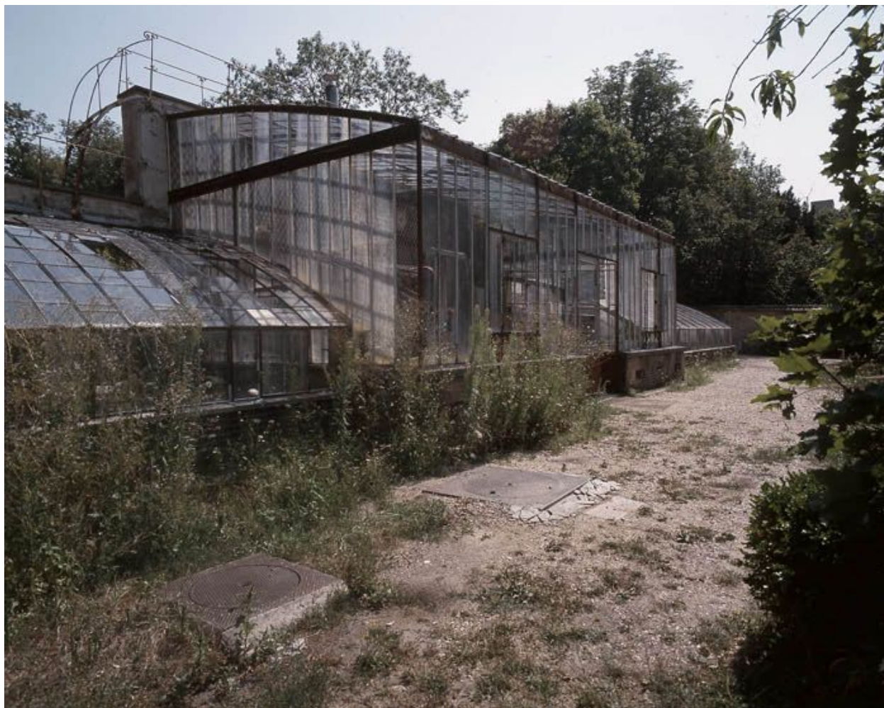
Partie centrale de la serre située dans l'ancien potager, au sud-ouest du bâtiment de la communauté.
