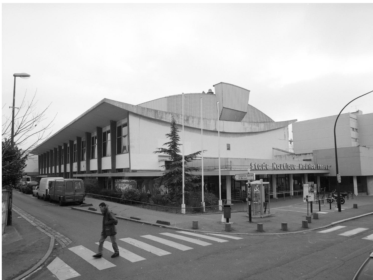
Façade principale : vue d'ensemble.
