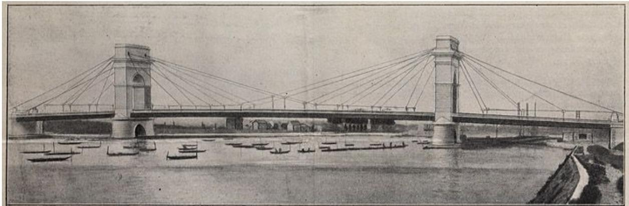
FIG. 6. — PONT SUSPENDU GISCLARD, SUR LA SEINE, A VITRY : Vue d'ensemble d'après le projet définitif.
