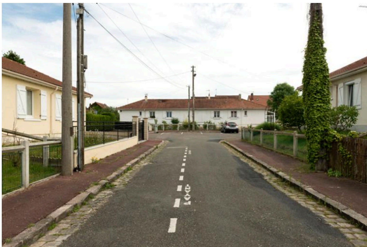
Impasse du lotissement du type Castor, rue Toutain.
