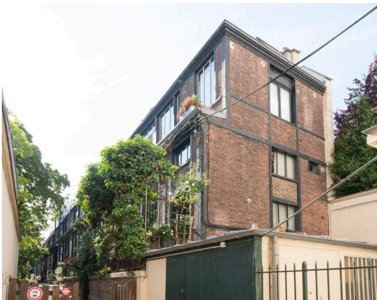
Vue des premiers ateliers de l'allée (2)
