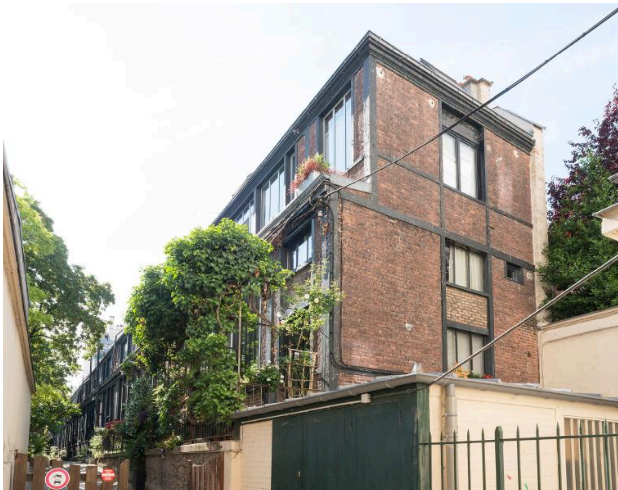
Vue des premiers ateliers de l'allée (2)
