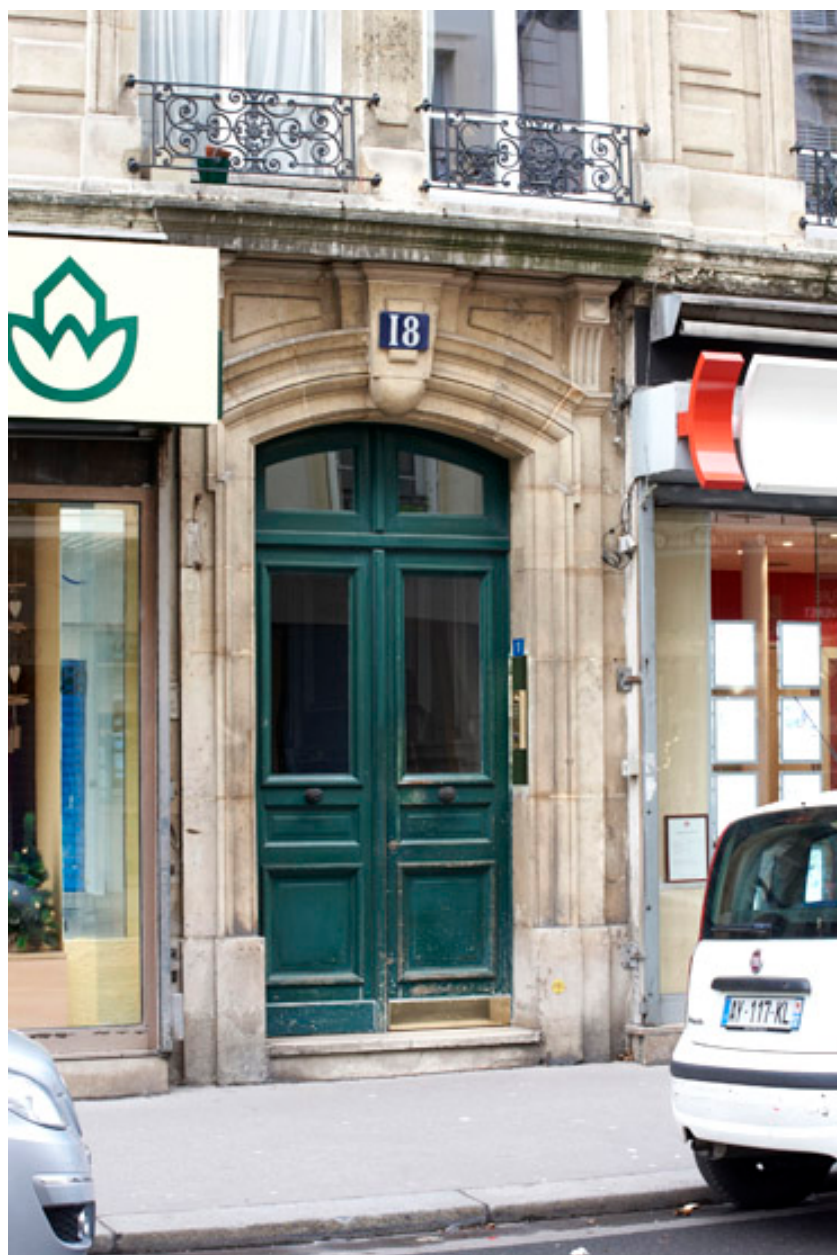
Porte batarde de l'immeuble.
