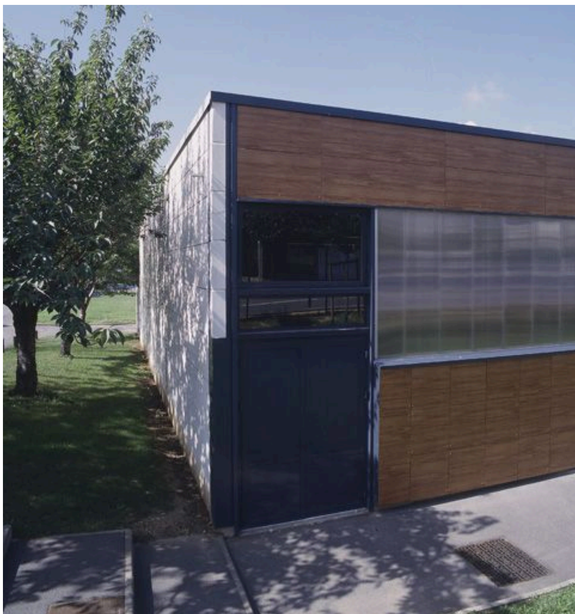
Porte métallique à double battant d'évacuation du gymnase.
