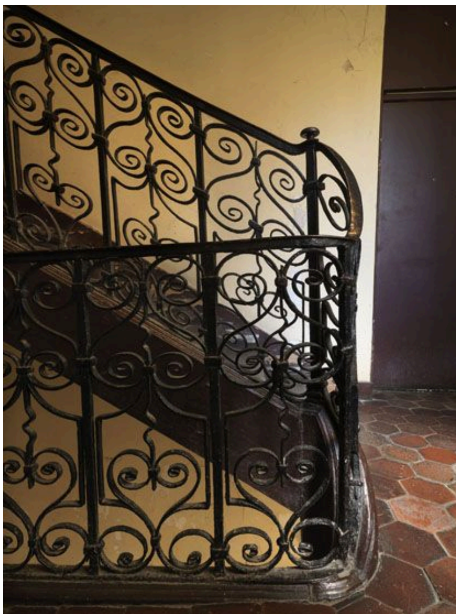
Balustres droits et balustres rampants.
