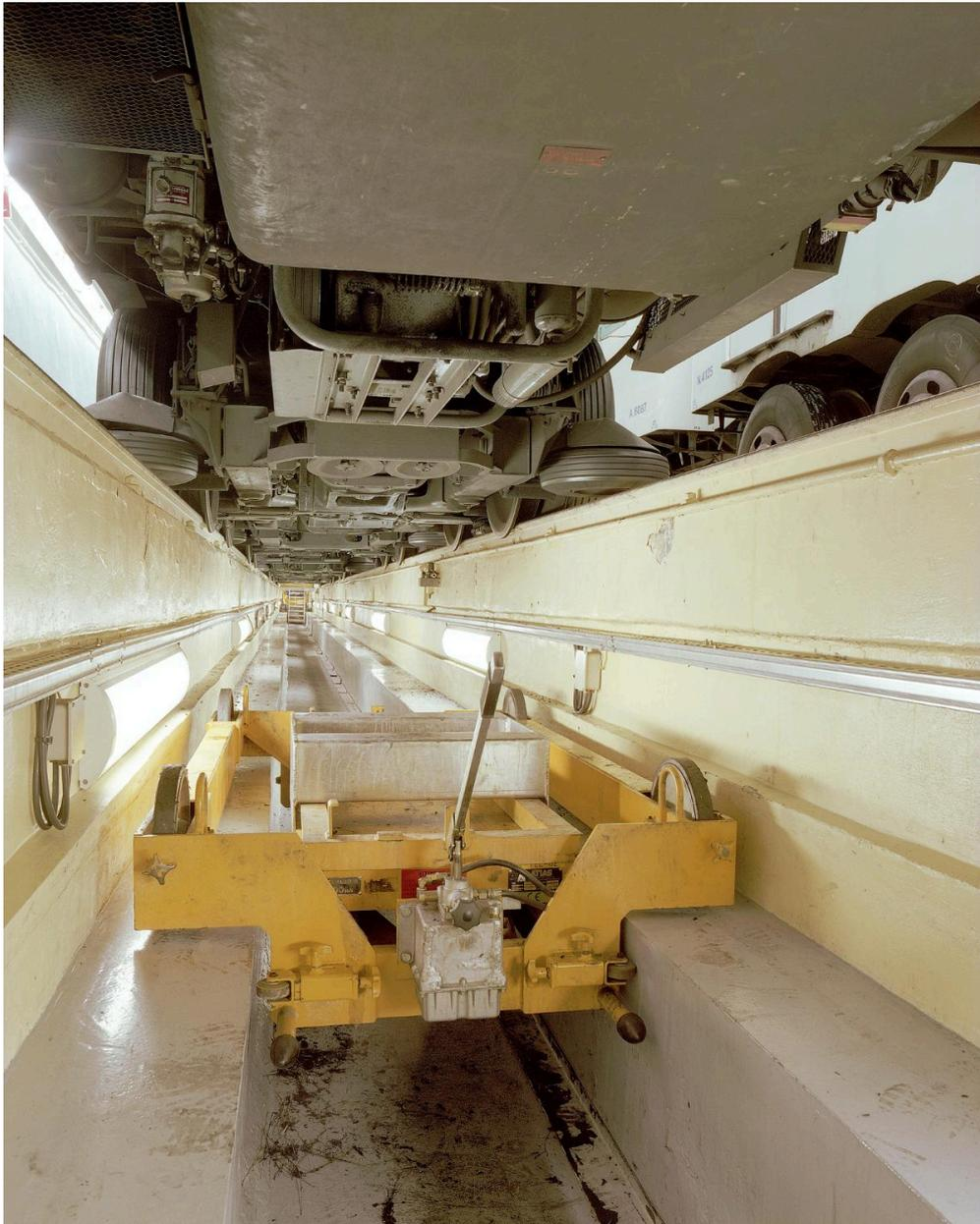
Fosse de la voie G. Table élévatrice en position, avant descente d'un compresseur.
