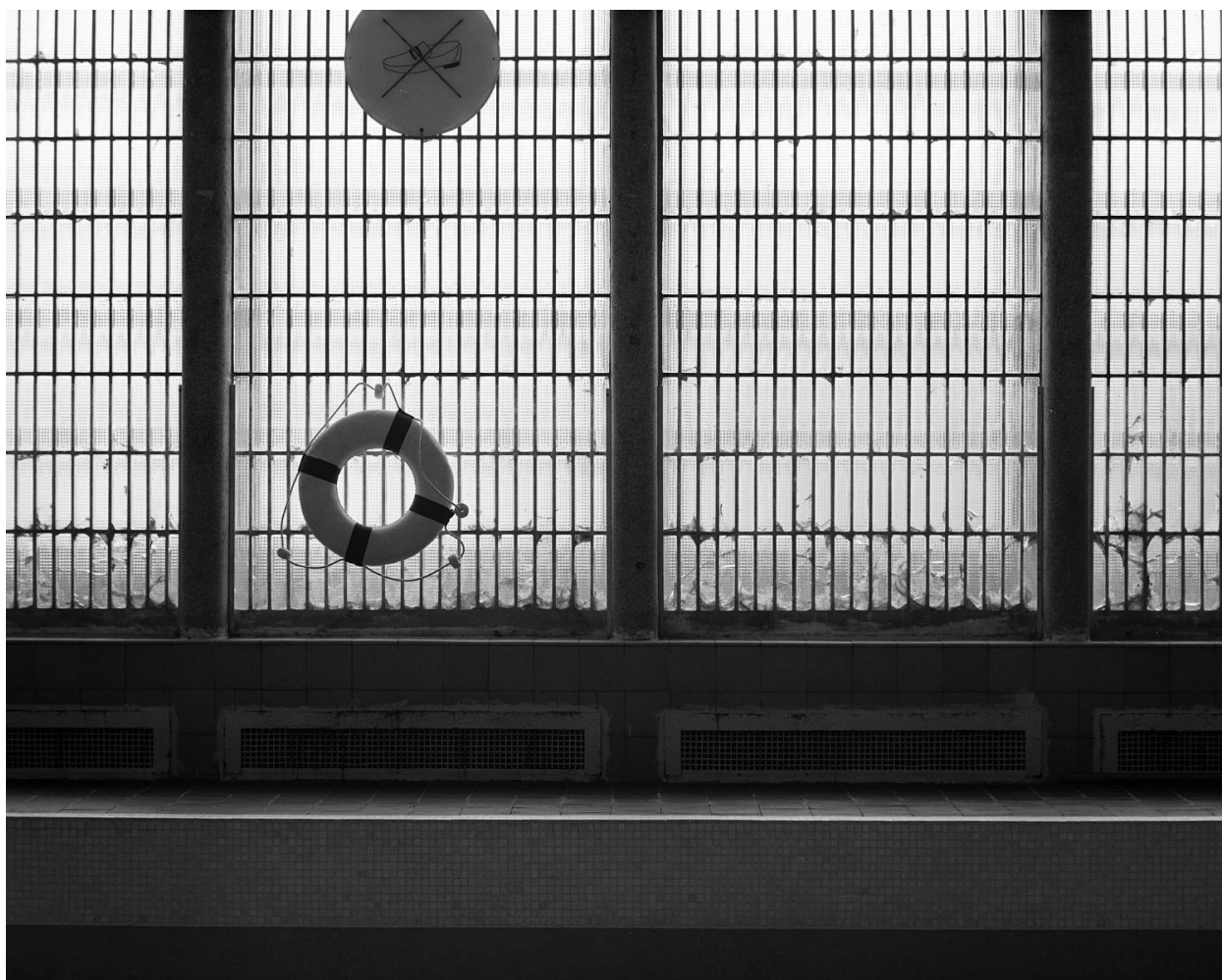
Piscine. Détail de la paroi intérieure de la façade. Ecole maternelle, école primaire de garçons, école primaire de filles dites groupe scolaire Marius Jacotot
