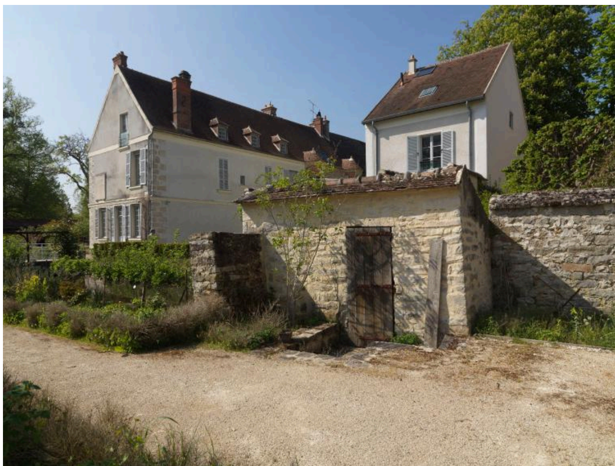
Vue du mur de cloture
