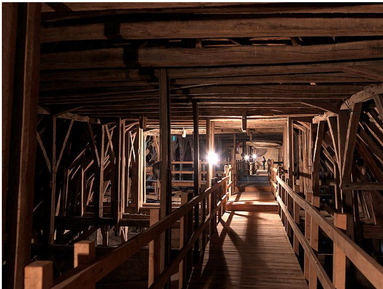
La charpente du vaisseau central : vue d'ensemble, de l'est vers l'ouest.
