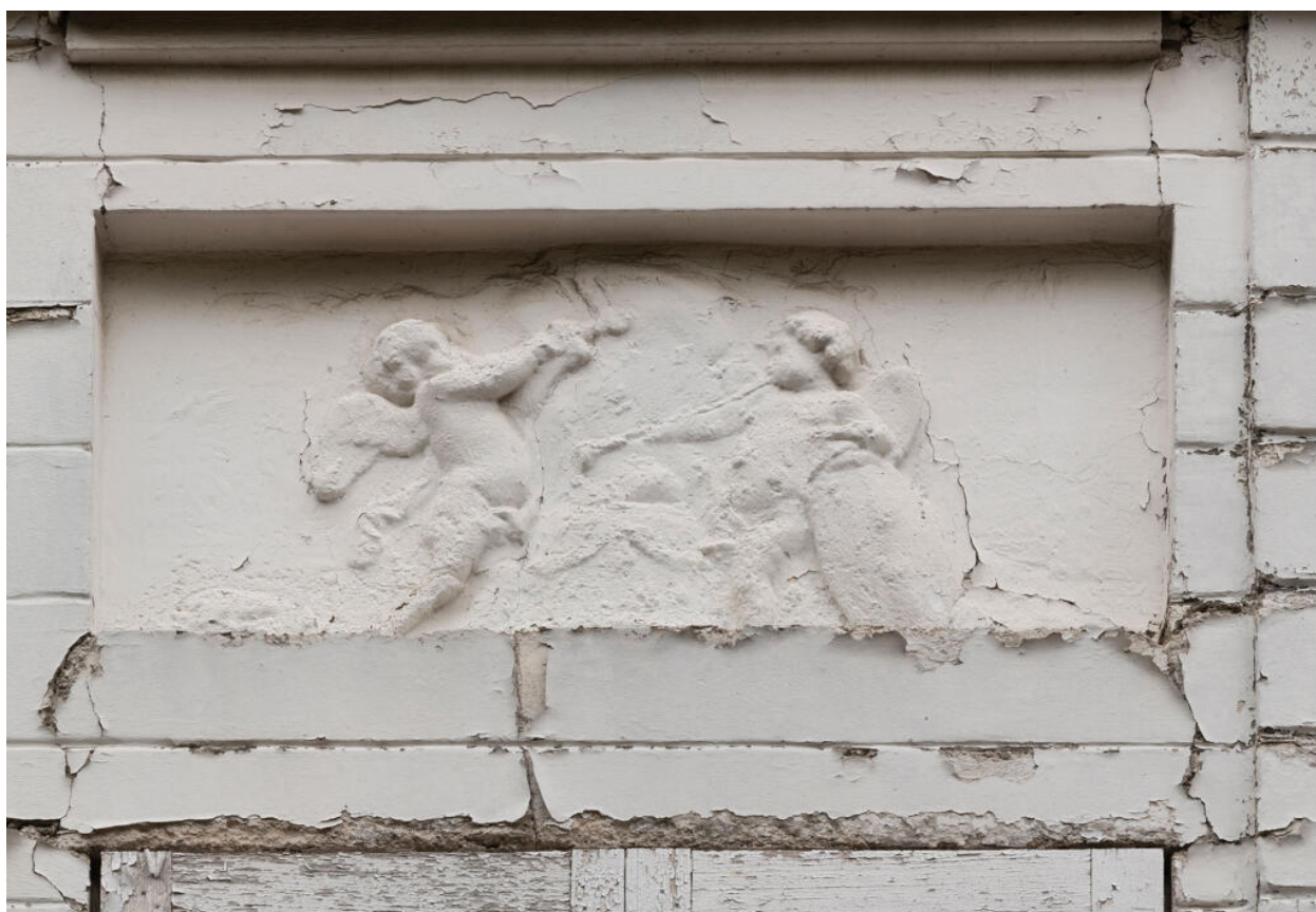
Façade sud, détail du bas-relief à droite.
