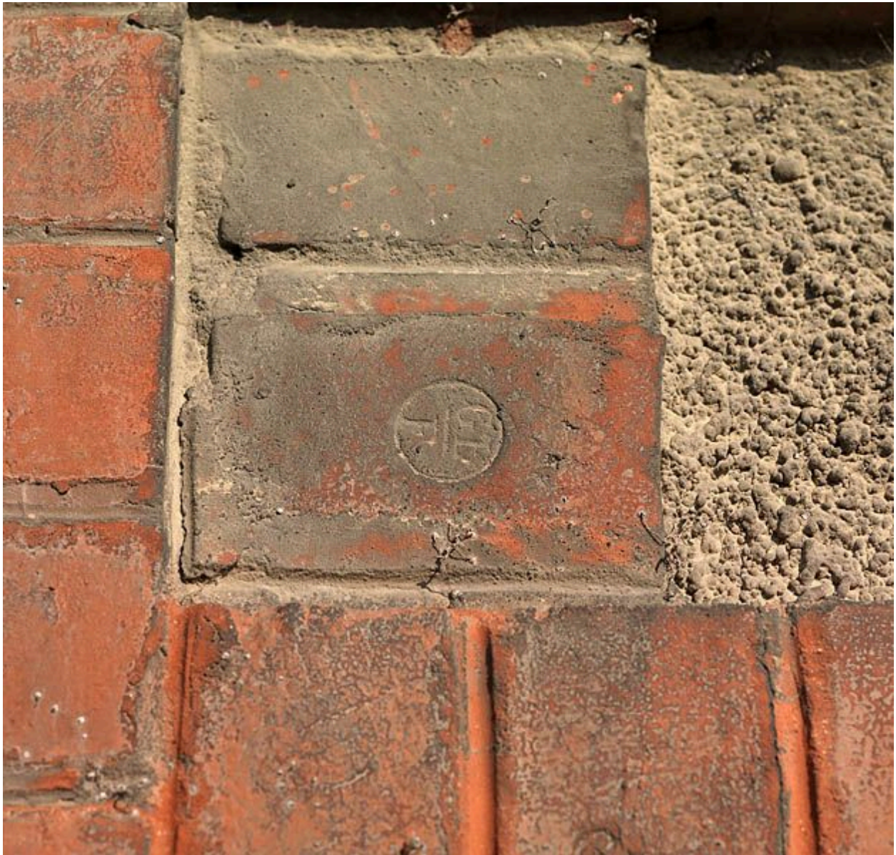
Détail d'un encadrement de fenêtre : briques marquées "GLF".
