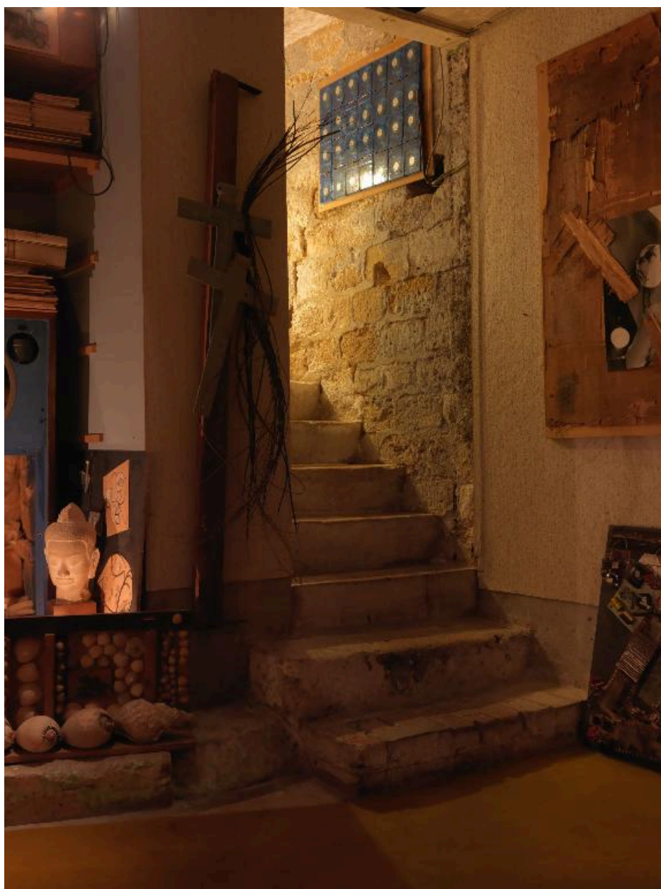
Départ de l'escalier à retour sans jour (sous-sol)
