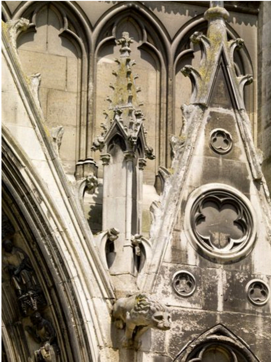
Détail du décor du portail : pinacle et sommet du gâble latéral droit.
