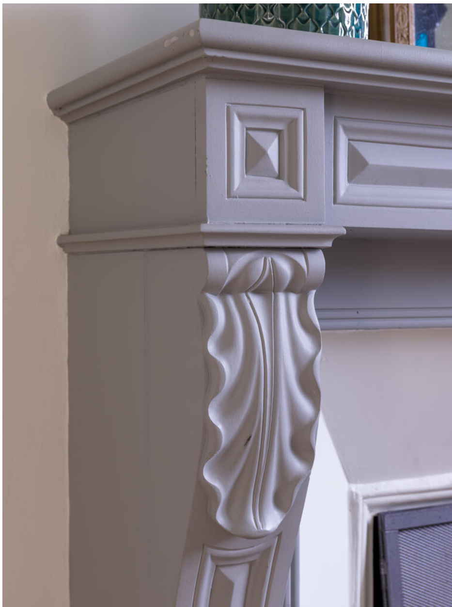
Vue de détail de la cheminée de la pièce nord-ouest.
