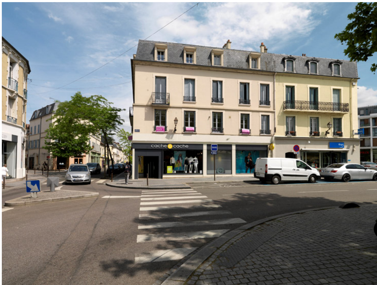
Immeubles, place de la République. Façade donnant sur la place.
