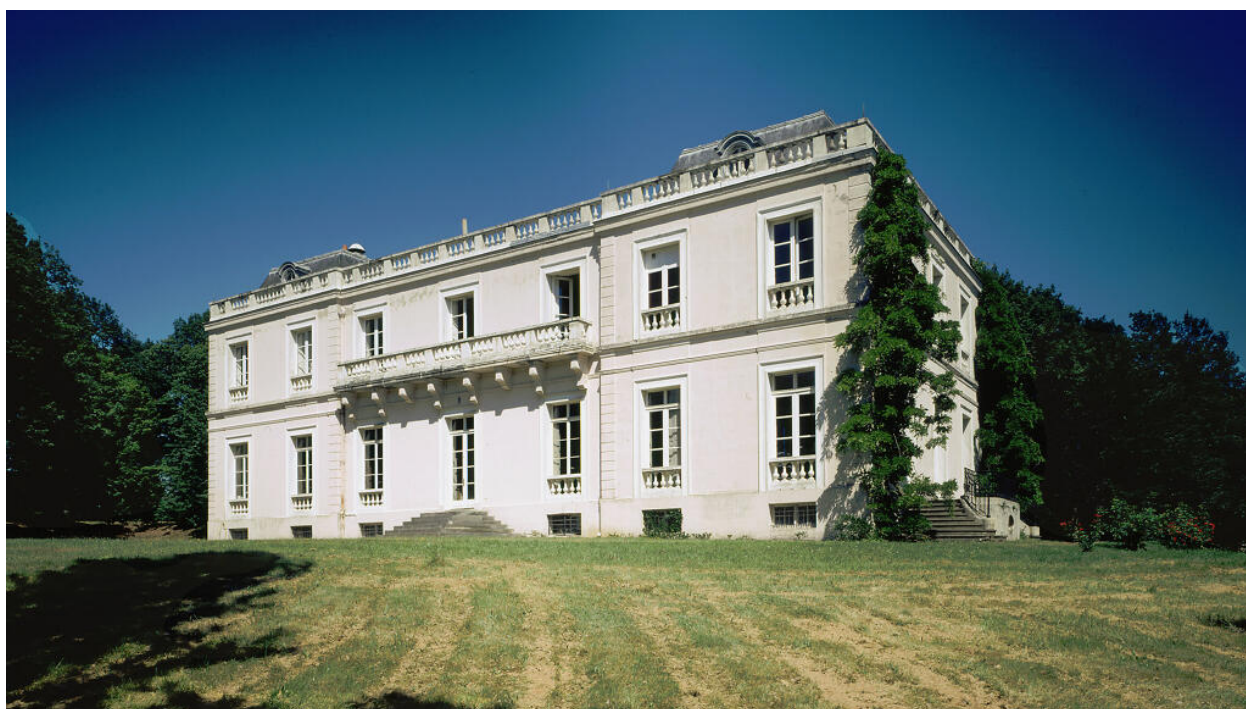
Vue d'ensemble de la façade principale. Maison de notable dite château du Bois du Rocher, actuellement musée de la photographie
