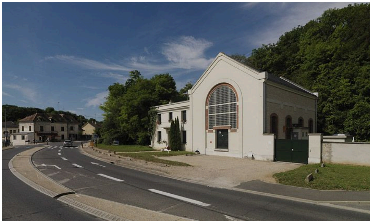
Station de pompage et logement de contremaître.
