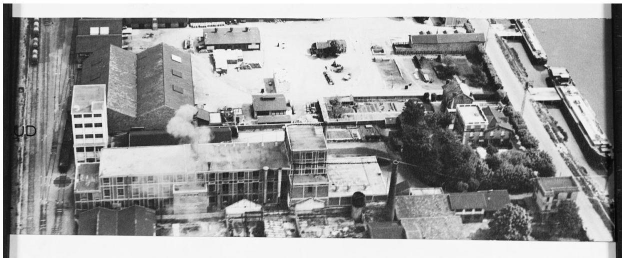
Vue d'ensemble des bâtiments avant le sinistre.
