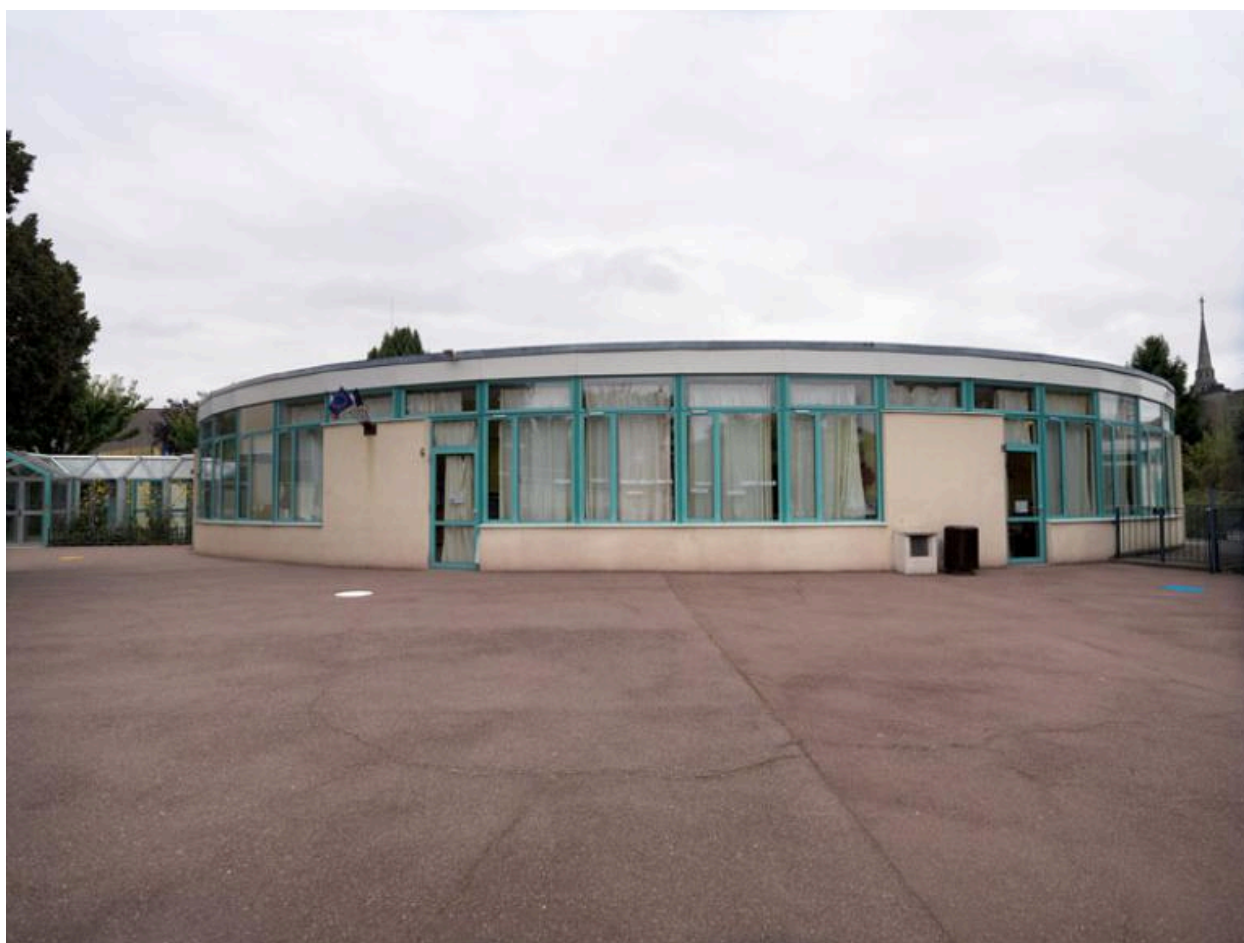
Vue générale de l'école et de sa rotonde.
