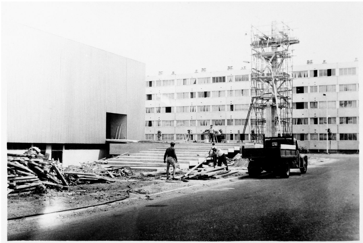
Construction de l'église et de la croix, place des Quatre Voyes. Juillet 1962.
