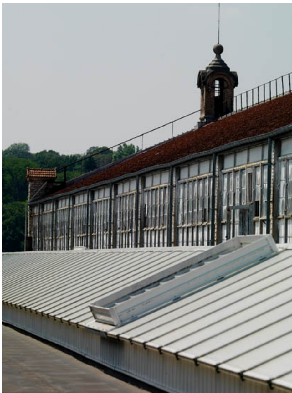
Les grandes verrières de la nef centrale. Au sommet, un clocheton.
