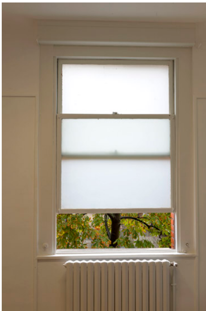
Vue d'une fenêtre de la loge du concierge.
