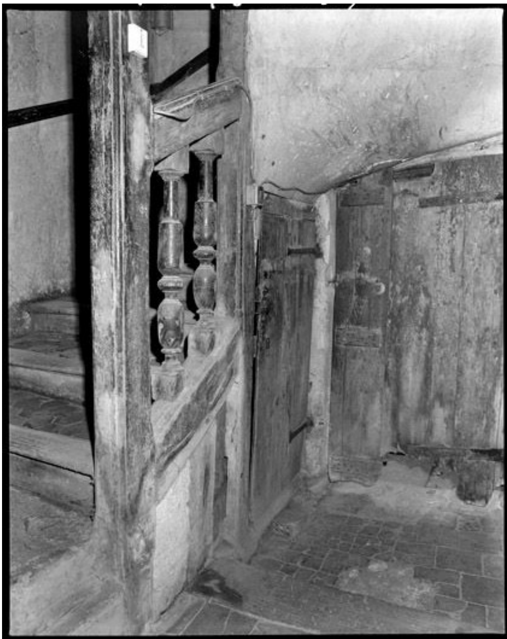
Maison, Sangle (rue de la) 10. Le départ de l'escalier rampe sur rampe.
