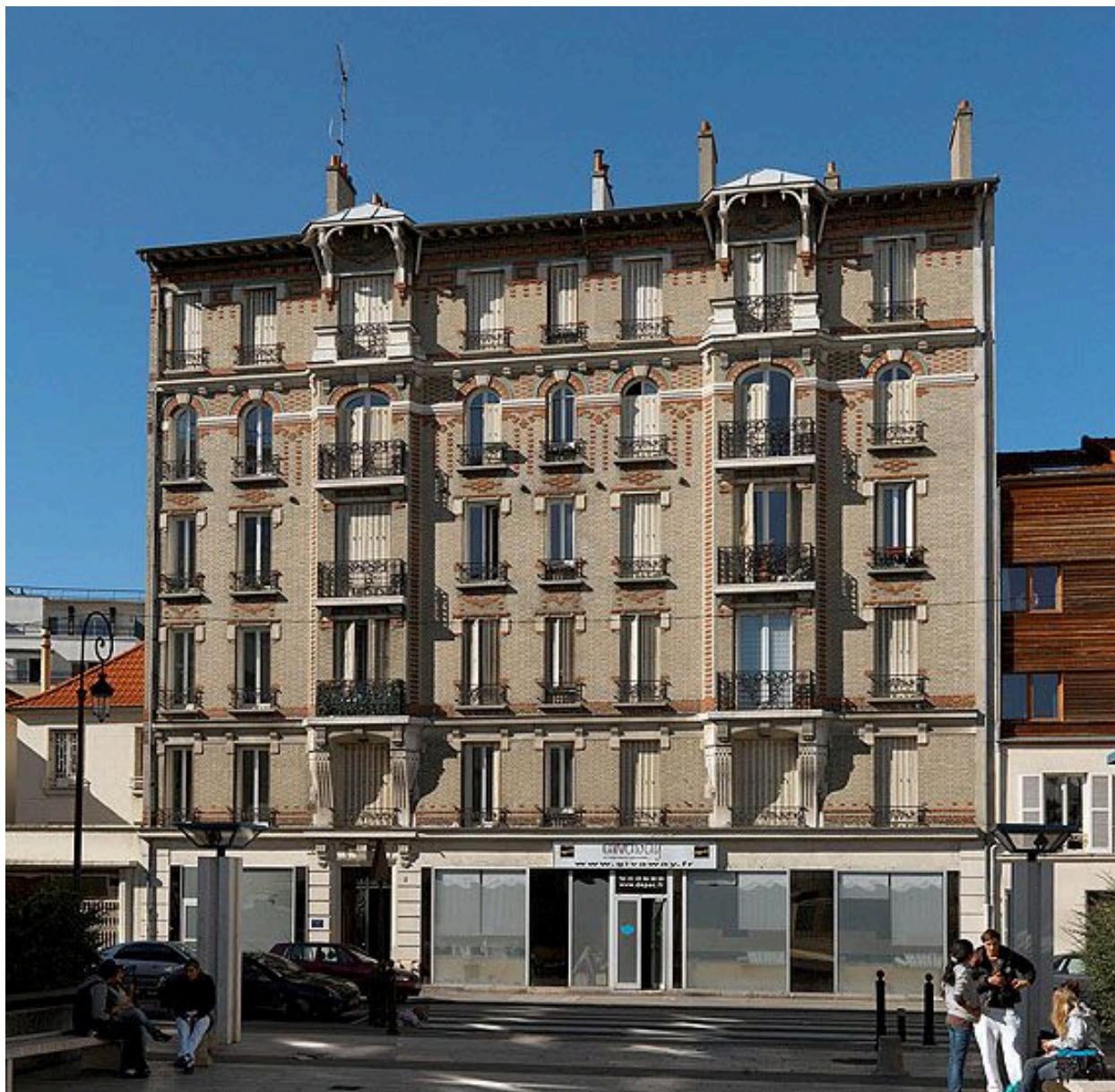
92, Suresnes, immeuble, 159 rue de Verdun. Elévation de la maçonnerie de brique de qualité sur la façade antérieure.
