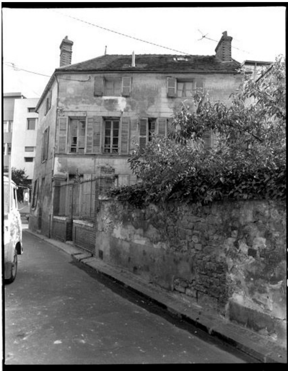
Maison, Cadotte (rue) 5. La porte arrière sur la rue Tellerie.
