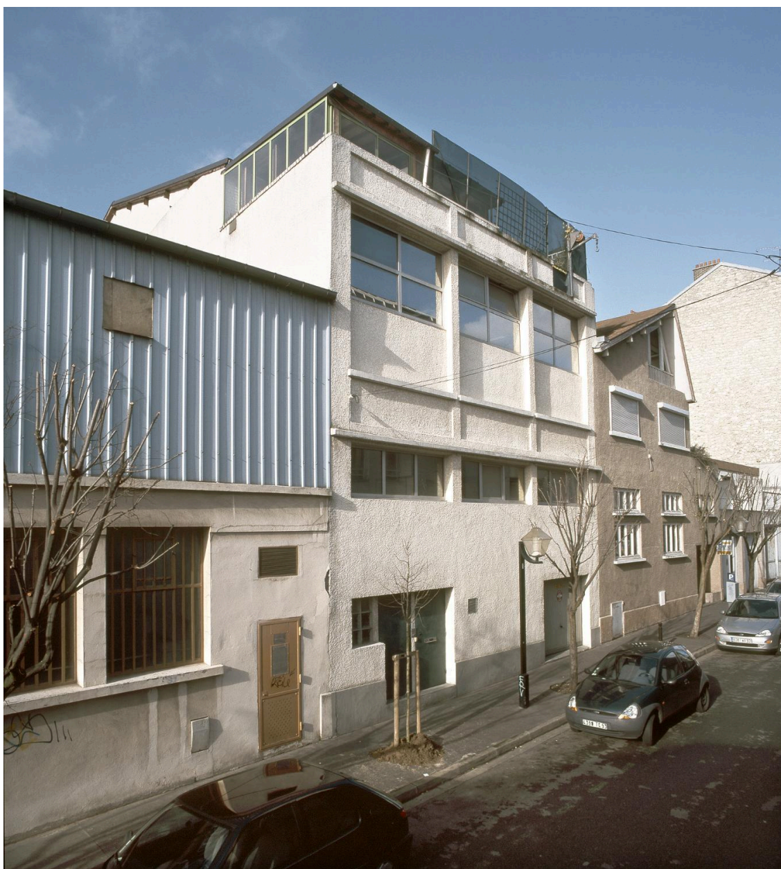
La façade des ateliers de polissage (au rez-de-chaussée) et d'électrolyse (à l'étage), rue Esther-Cuvier.
