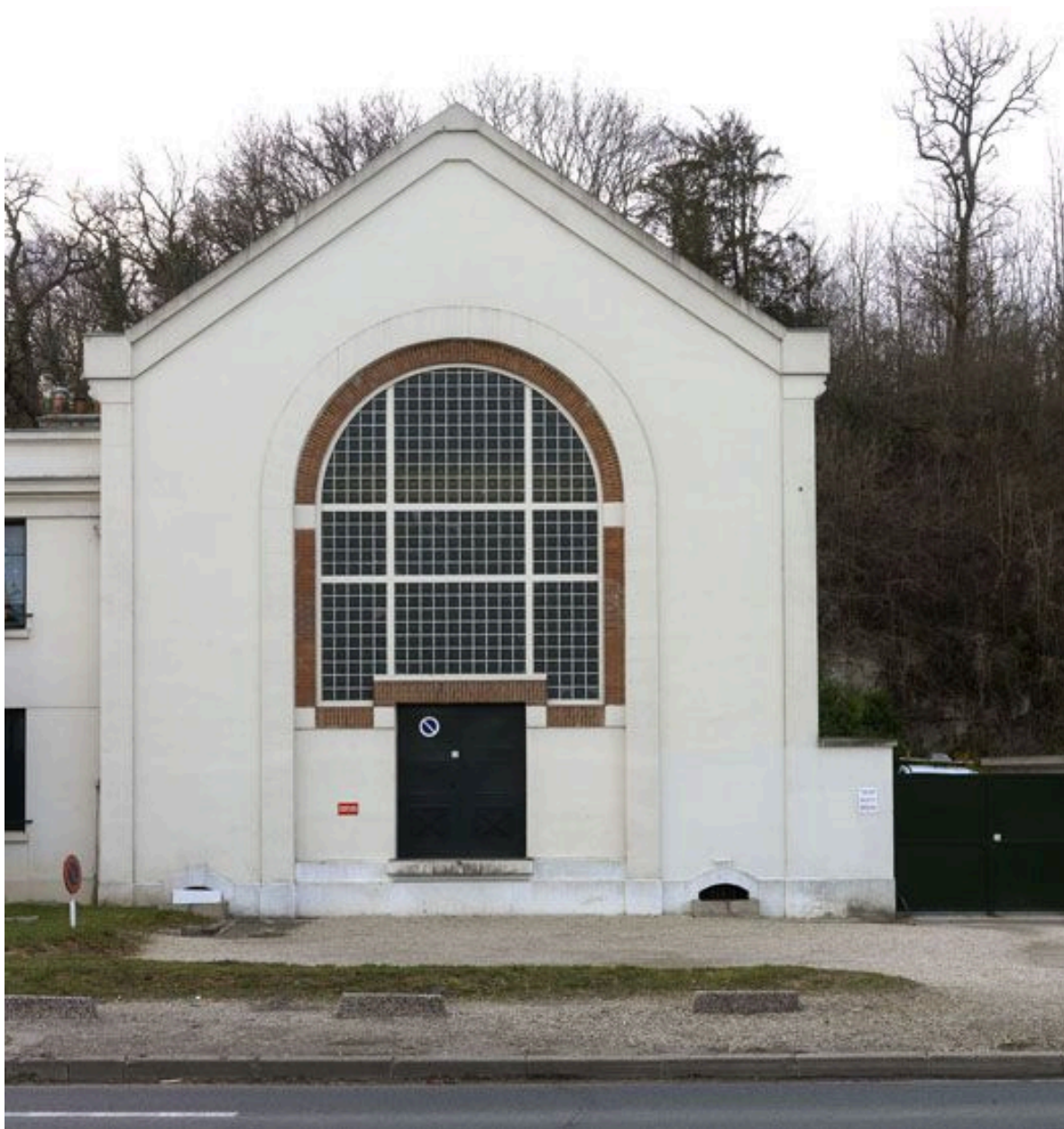
Bâtiment des pompes, pignon sur rue.
