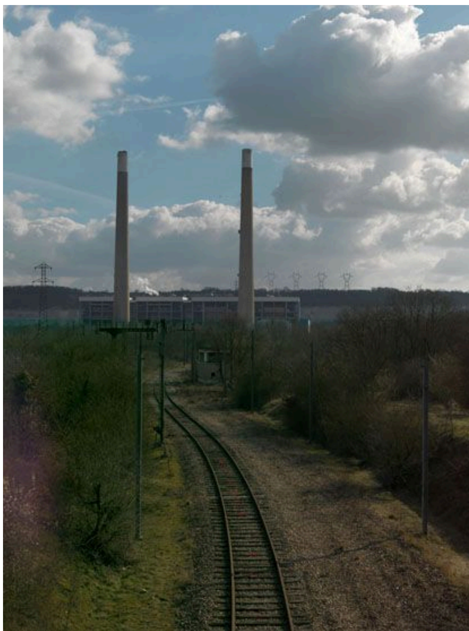
Porcheville, vue de la centrale EDF.
