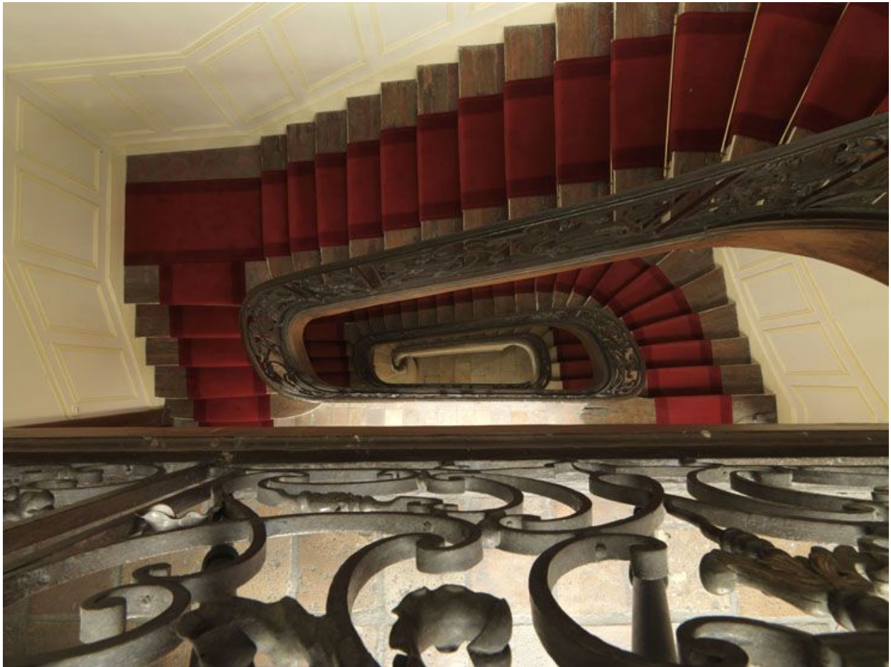
Vue en plongée du vide central.
