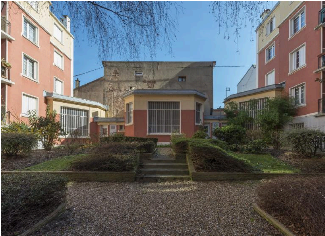
Vue des ateliers situés au rez-de-chaussée (6)
