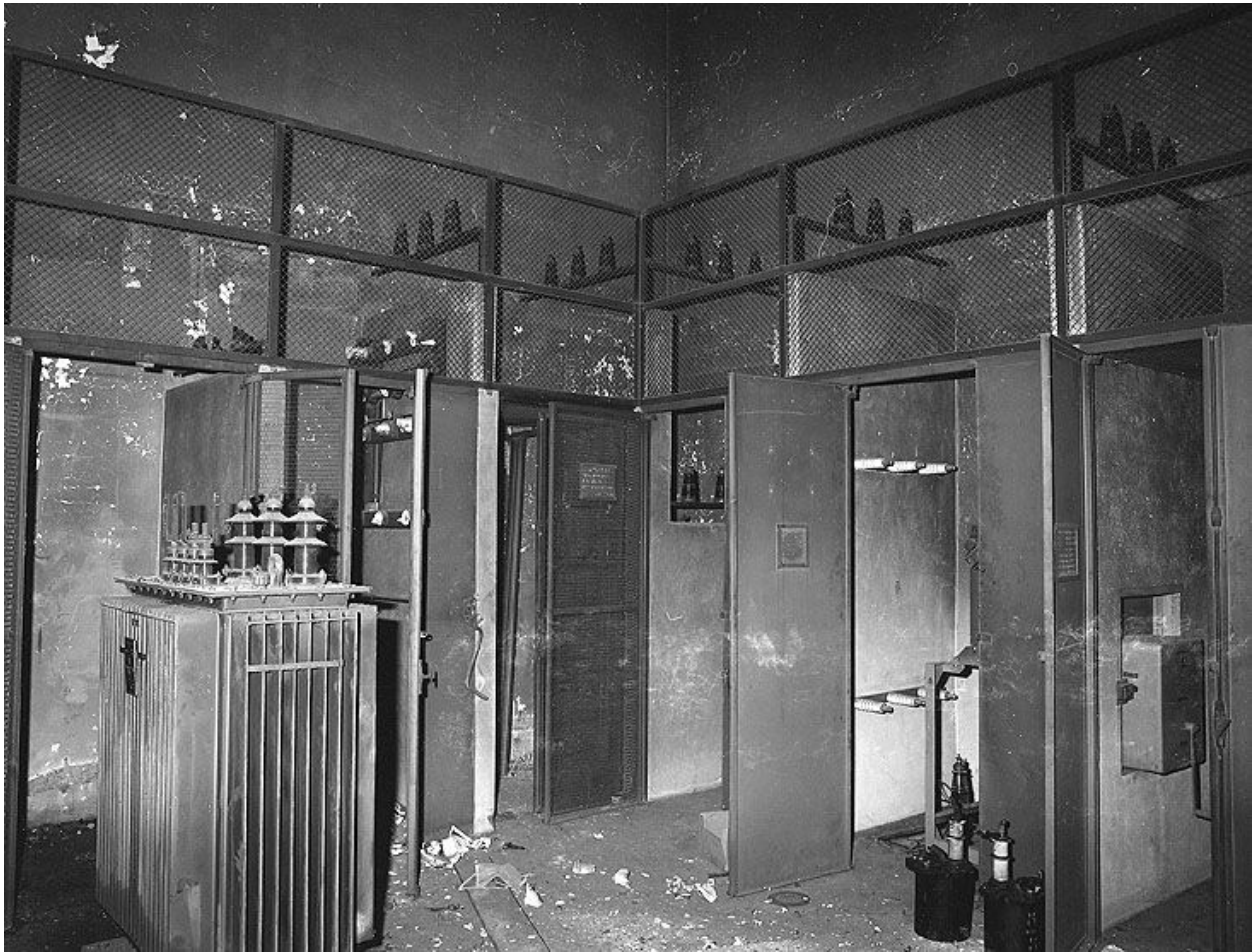
Chaufferie - Commandes arrières. Campagne photographique, lors de la destruction du bâtiment en 1976.
