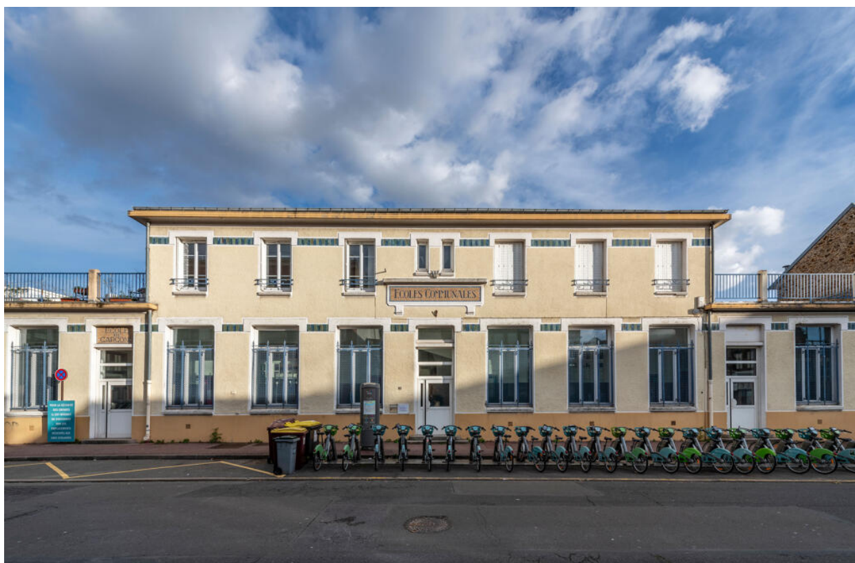
École des Coteaux, bâtiment de 1922, façade ouest. Architecte : Henri Renard.
