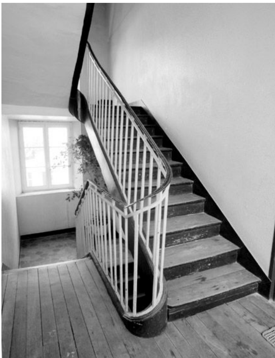
L'escalier du corps de bâtiment oriental.
