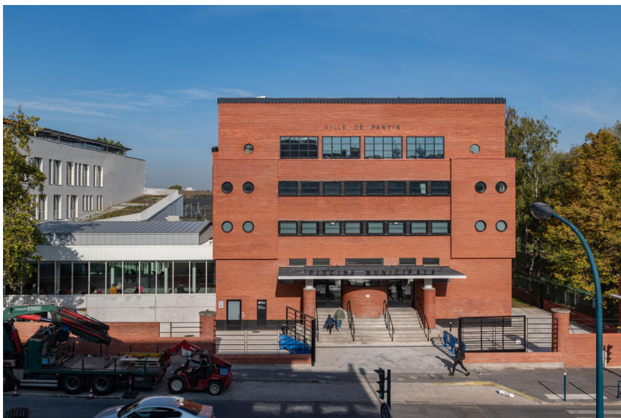
Piscine Alice Milliat. Façade principale.
