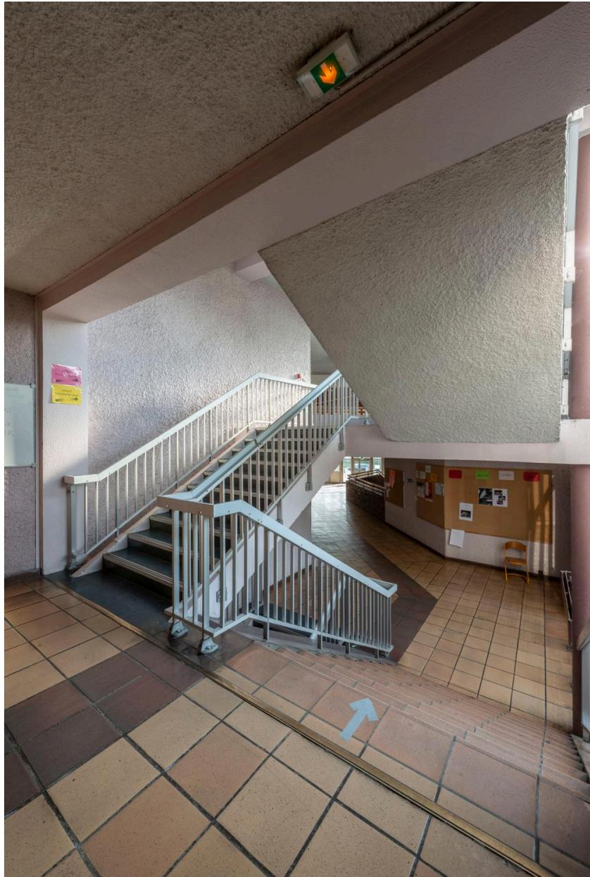
L'ossature du bâtiment est composée de poteaux en béton armé coulés en place, comme visibles à droite de l'escalier.
