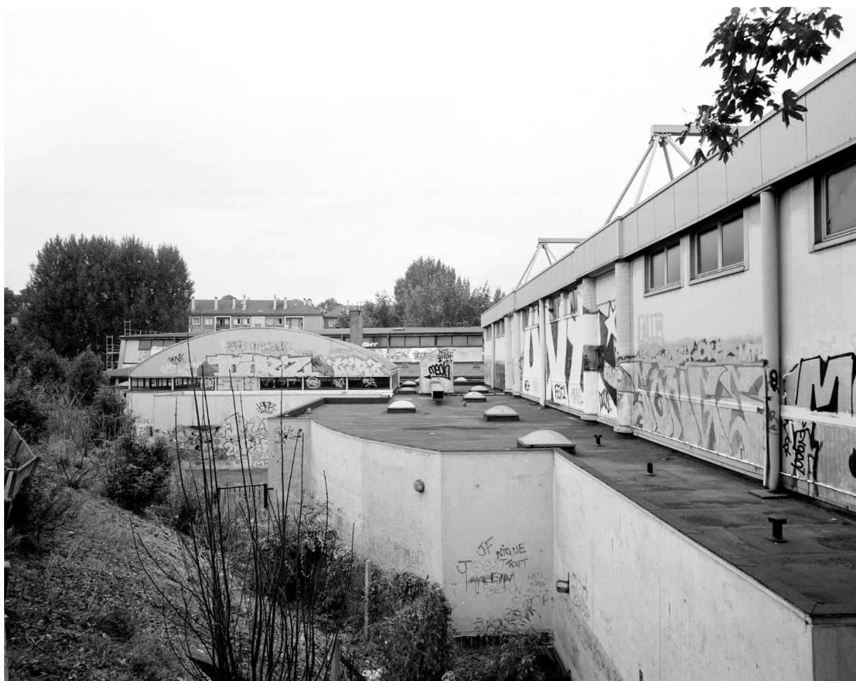
Vue du flanc est du gymnase P. Puchet et du flanc sud du gymnase Jules Ladoumègue
